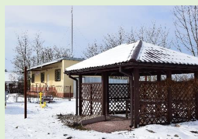
Świetlica wiejska w Szczytnikach
